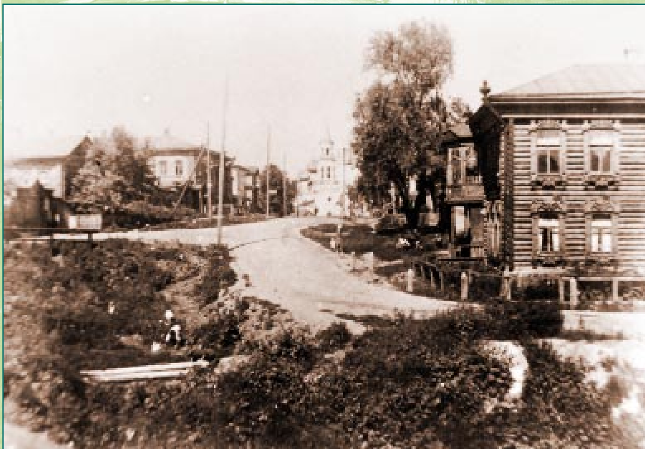
■ На перекрестке ул. Калачной (ул. Венецкого) и Алешковской (ул. Кашина).
